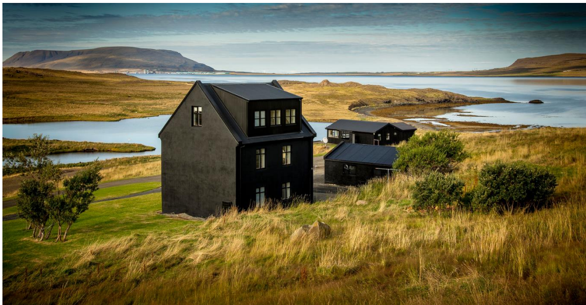
Mynd 2. Uppgerð hús í ægífögru umhverfi Hvalfjarðar.
