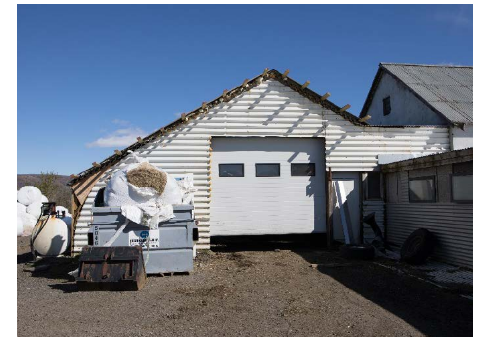
Mynd 32. Geymsluaðstaða fyrir slökkvibúnað í Kjósarhreppi.
